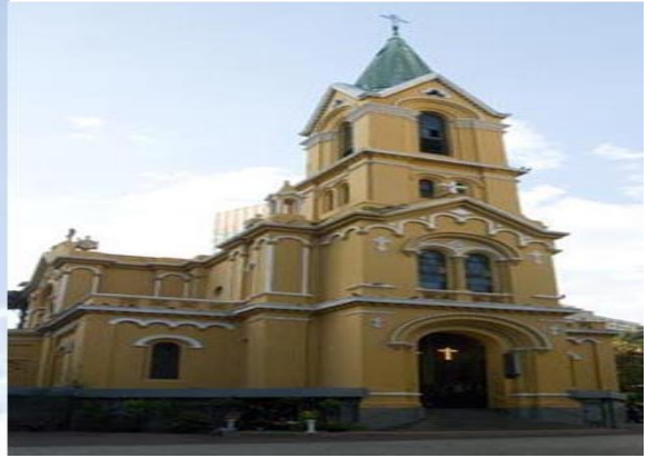
FIG.:18 Frontal da Capela, entrada dos fiéis
