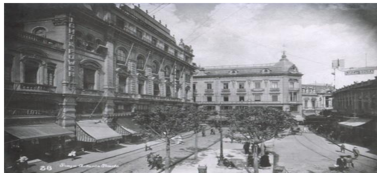
FIG.:10 Após a demolição da Capela - Praça Antonio Prado e ao fundo antigo Prédio Martinico
