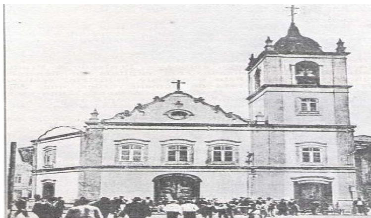
FIG.:6 Antiga Capela no Largo do Rosário, frontais fachadas tradicionais com cornijas retas e óculo acima das janelas.
