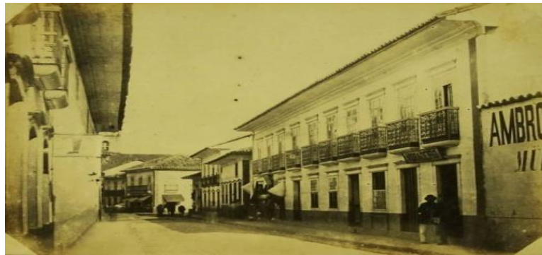
FIG.:4 Casas baixas e sobrados de taipa de pilão, ano 1862, Rua Direita.
