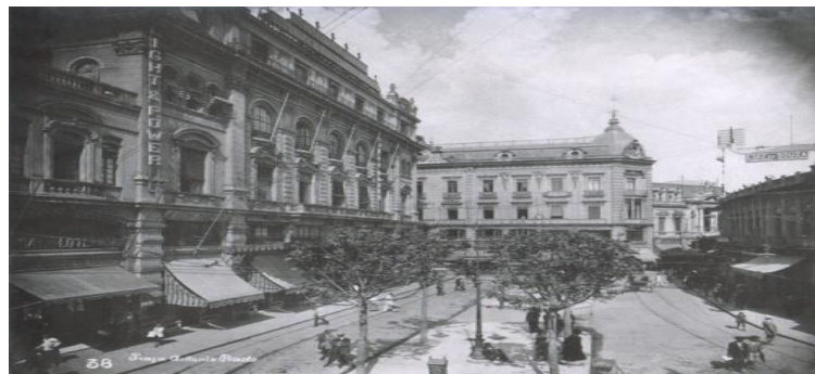
FIG.:10 Após a demolição da Capela - Praça Antonio Prado e ao fundo antigo Prédio Martinico
