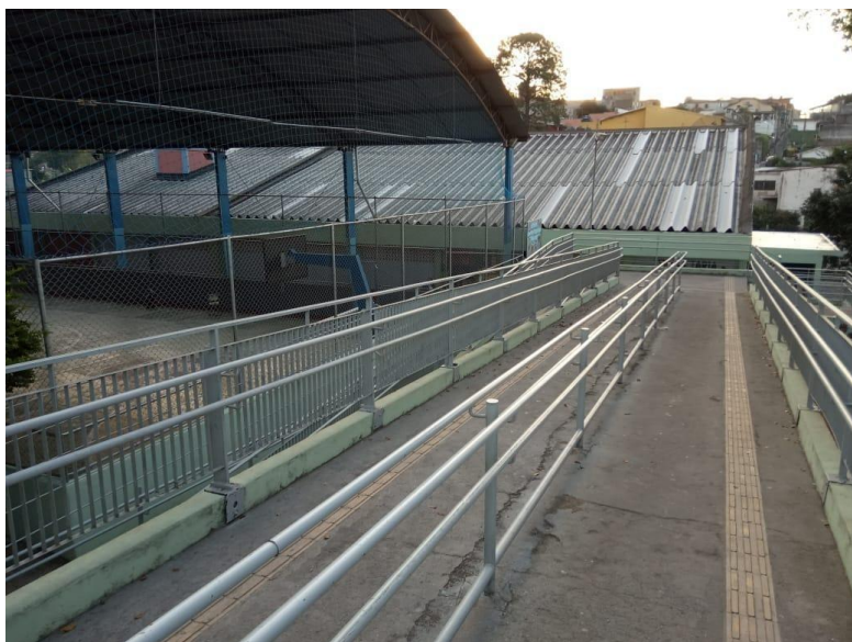
Entrada da EMEF Quirino Carneiro Rennó.
