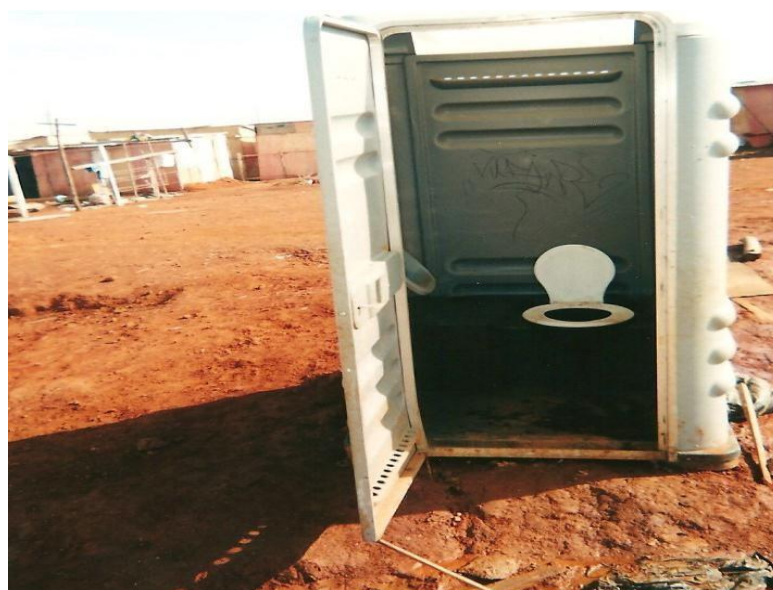
Figura 3: Banheiro coletivo do assentamento
