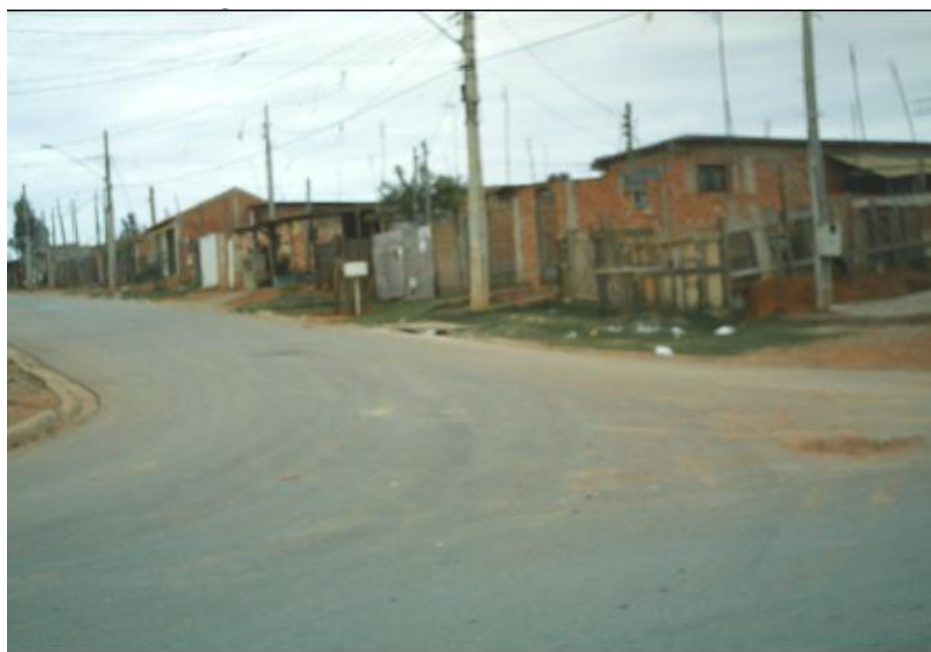
Figura 8: Bairro do Habiteto depois da pavimentação asfáltica-2005.
