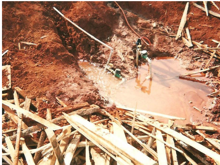
Figura 4: Torneiras para uso coletivo do Assentamento
