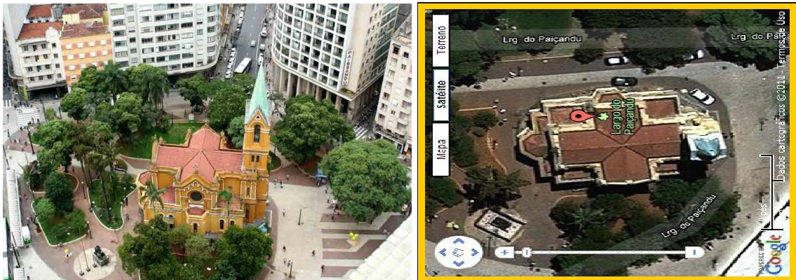
FIG.:15 É a 1ª Capela construída com estilo neo-românico FIG.16 Imagem satélite - planta alta
