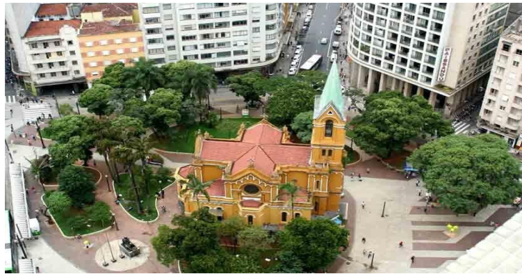
FIG.:11 Capela Nossa Senhora do Rosário dos Homens Pretos, estrutura neo-românica
