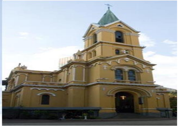
FIG.:18 Frontal da Capela, entrada dos fiéis
