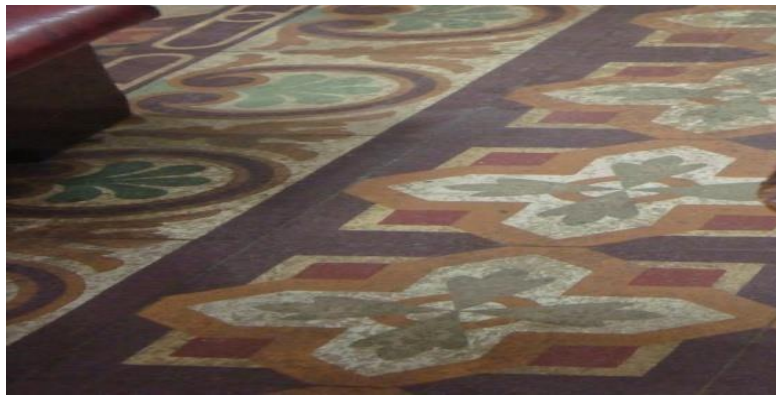
FIG.:33 Piso do corredor central da Capela
