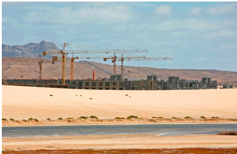
Obras de empreendimento hoteleiro na orla de Boa Vista: sem cuidado, imóvel pode comprometer o processo de desova das tartarugas cabeçadas (Imagem: Turtle Foundation)
